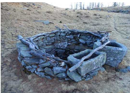
La cisterna della Colmine di Fuori
