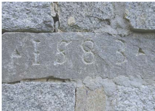
La data incisa sull'architrave di una casa testimonia l'antichità del borgo
