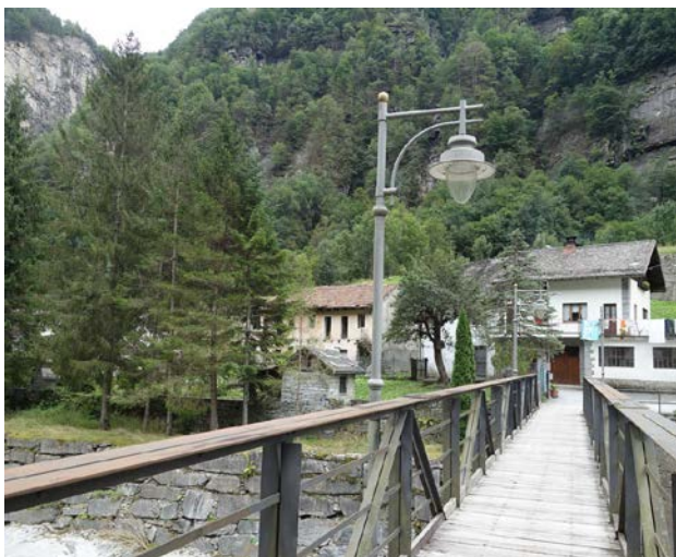
La passerella pedonale sul torrente Diveria segna l'inizio dell'escursione
