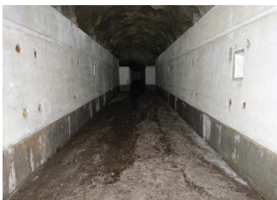
Il salone-dormitorio all'interno del forte
