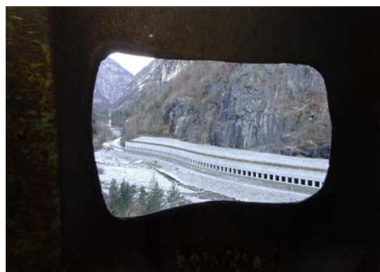
Dalle finestre del forte si poteva controllare la strada che conduce al Passo del Sempione
